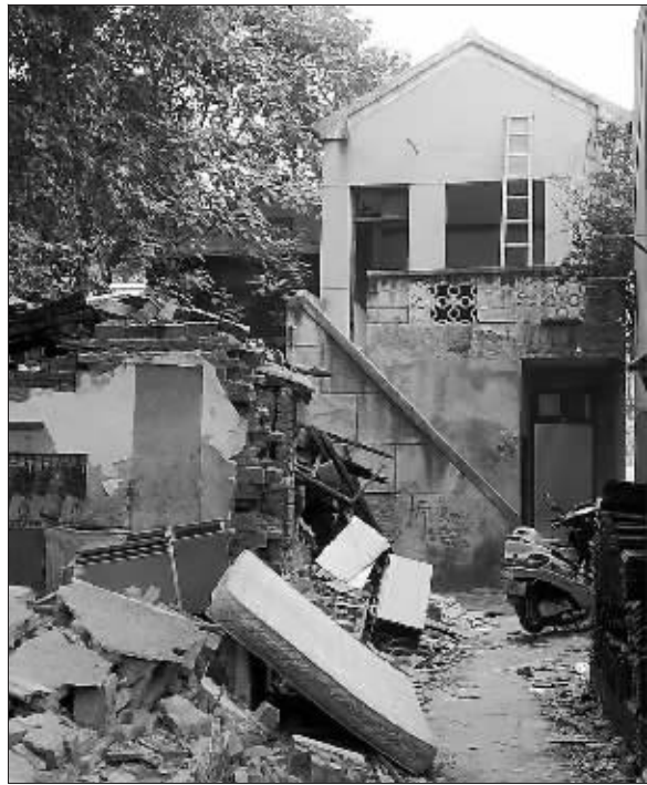
李女士摔伤的拆迁工地
