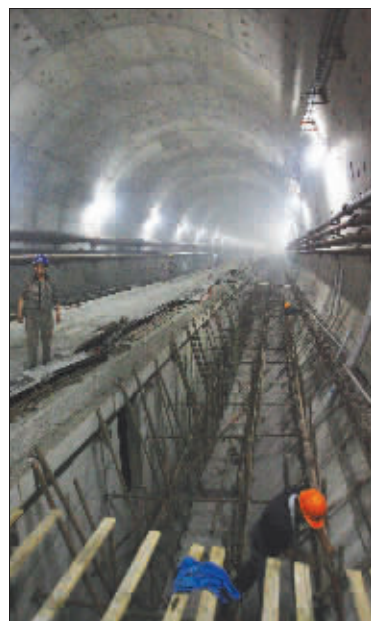
2009年5月19日,施工中的长江隧道 快报记者 泱波 摄
