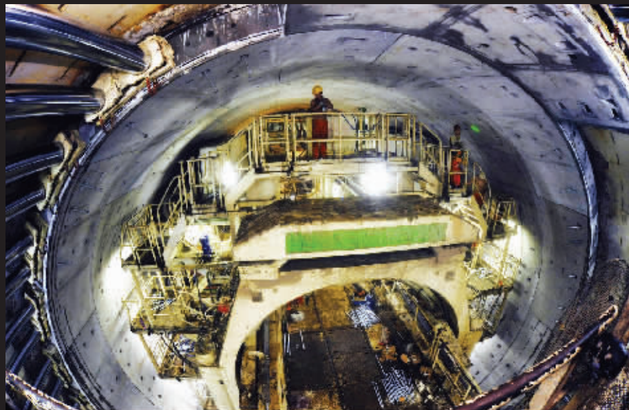
2009年7月16日,巨型盾构掘进机成功穿越江中极险段——冲槽超浅覆土段,正以每天20米的进度,向最后650米冲刺 CFP 供图
