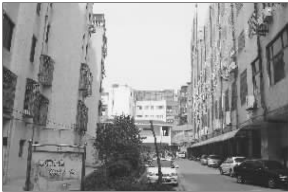
正在装修的歌厅外墙密布空调线 陈超 摄
