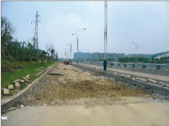
一条辅路已开始施工
