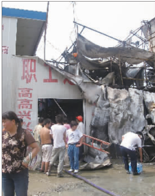
宿舍被大火烧得只剩一层,工人家的家当被烧个精光
