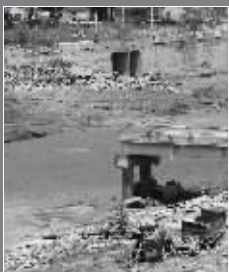
桥梁完全断裂 新华社记者 陈键兴摄
