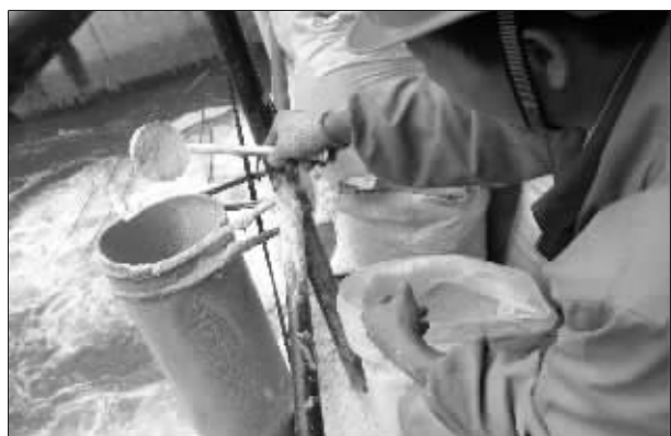
城河节制闸治污现场,民工正在向管道里添三氯化铁 快报记者 邢志刚 摄
