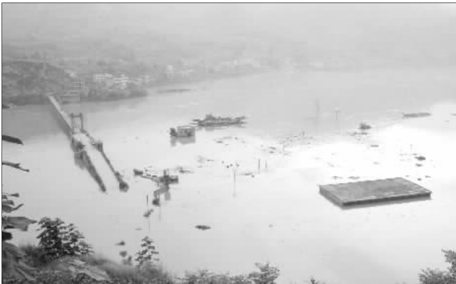
被冲断的大桥(8月7日摄) 新华社发(刘勇摄)
