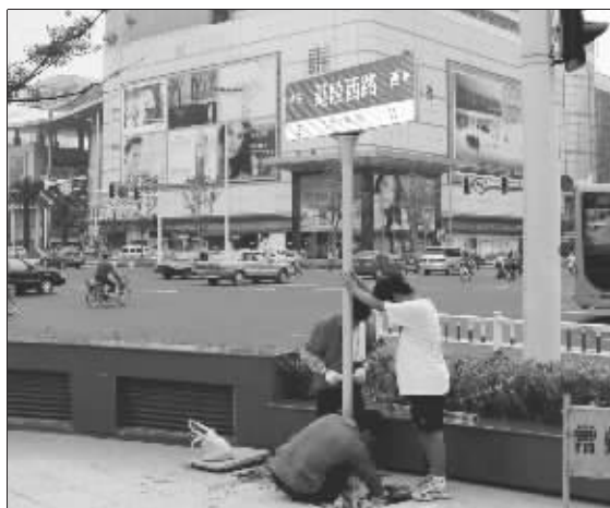
工人们正在延陵西路竖路牌
