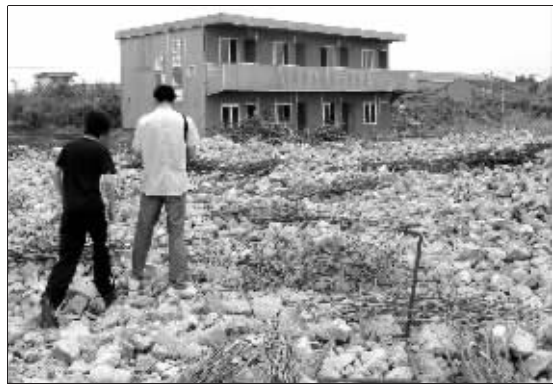
旧梁板已被砸碎
