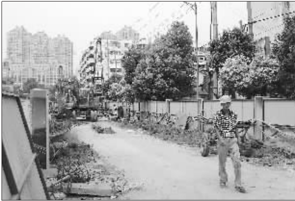
►施工工地紧挨着小区
