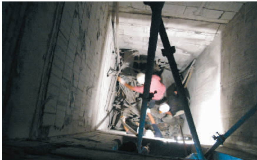
黑洞洞的电梯井险些要了民工的命
