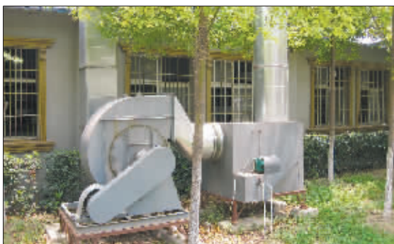
涂层企业加装的废气收集处理设备 陆媛 摄
