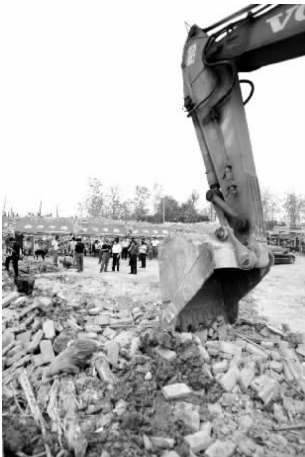
6月21日,挖掘机正在清理现场 新华社发(高微摄)
