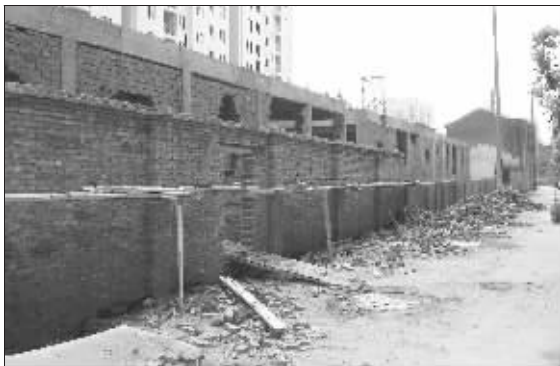
河埭街道的社区配套房昨天仍在施工 薛晨 摄
