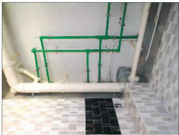
看到这么规整的施工工地,还有什么不能让人放心的?
