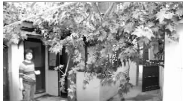
断枝砸在民房屋顶上,堵住了小院大门
