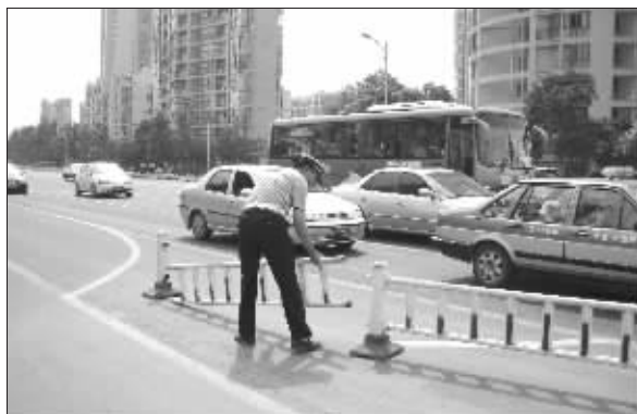
交警正在重新安装菱港桥被车辆刮倒的栏杆
