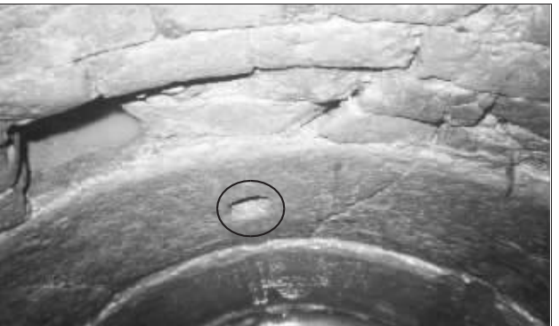
南朝砖井底部有玄机,图中画圈处即为渗水孔
