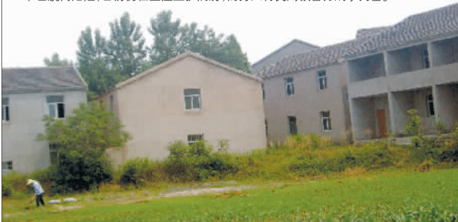
因风传拆迁,尹都庄不少村民加盖了房子
