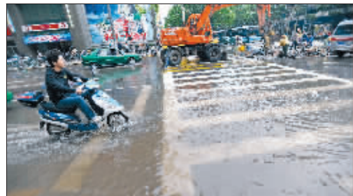
水管破裂,马路上一片汪洋 快报记者 施向辉 摄
