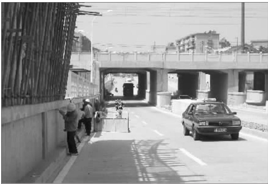
在学前东路风雷立交段作业的工人
