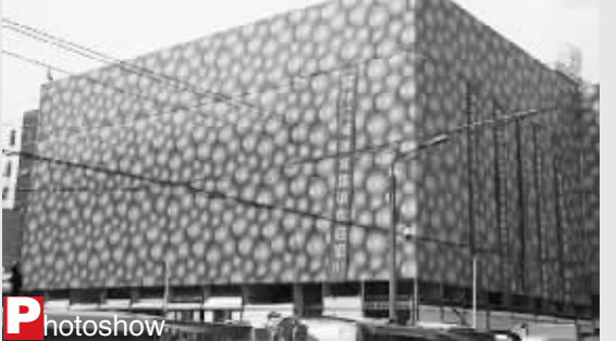
3月30日,河北省石家庄市金桥大街上的山寨“水立方”。这家卖裤子的商场别出一格,把商场外墙重新装修成水立方的模样。
