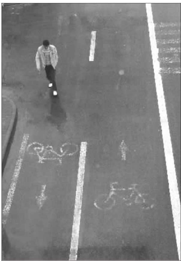
玄武大道集中在南侧的双向非机动车道
