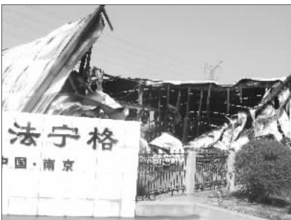
数千平米的厂房被烧塌
