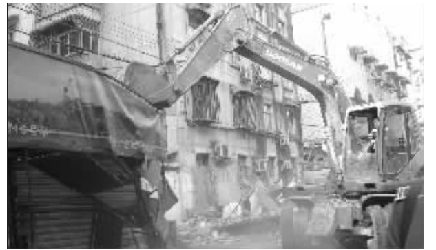
拆违现场 见习记者 李蓓超 摄
