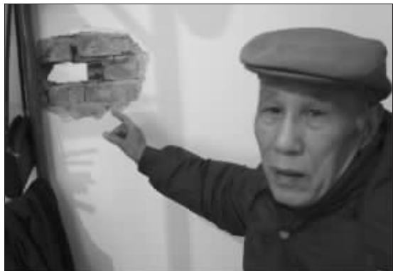
张老汉指着隔壁装修打出的洞,十分气愤 赵守诚 摄
