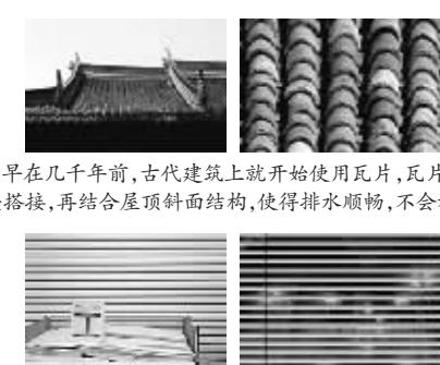
早在几千年前，古代建筑上就开始使用瓦片，瓦片间上下交叠搭接，再结合屋顶斜面结构，使得排水顺畅，不会积水。百叶窗起源于中国，是窗子的一种样式。百叶窗的叶片倾斜间隔、平行排列，既能起到遮挡视线和阳光的作用，又能保持通风顺畅。
