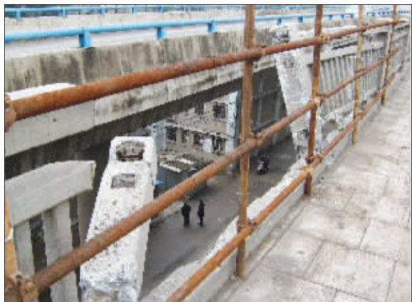
护栏撞坏的地方用钢管支架封了起来 快报记者 唐伟超 摄
