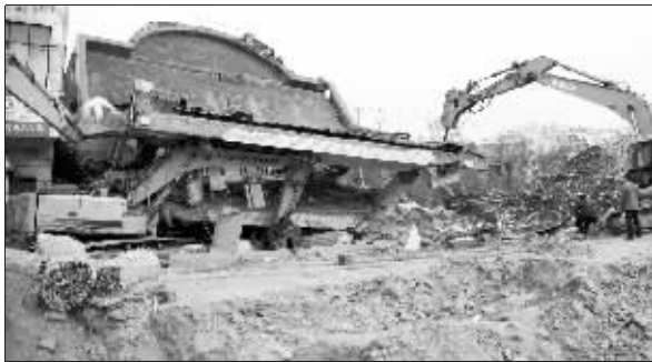
两辆挖掘机在拆除危险墙体,准备营救 新华社记者 王艳明 摄
