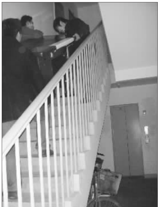
电梯停运,搬家也只好爬楼
