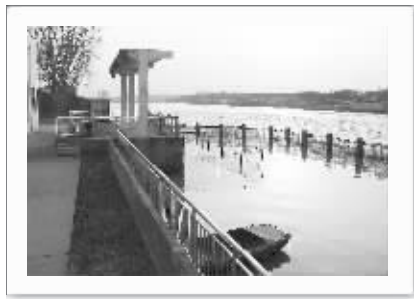
受污染的水厂取水口
