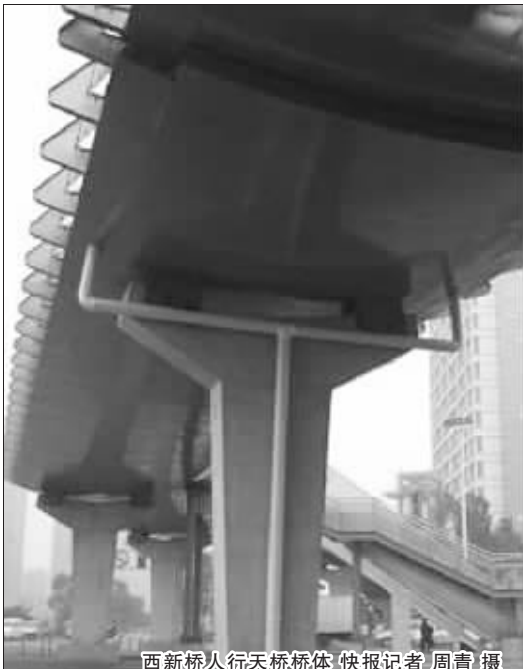
西新桥人行天桥桥体 快报记者周青摄
