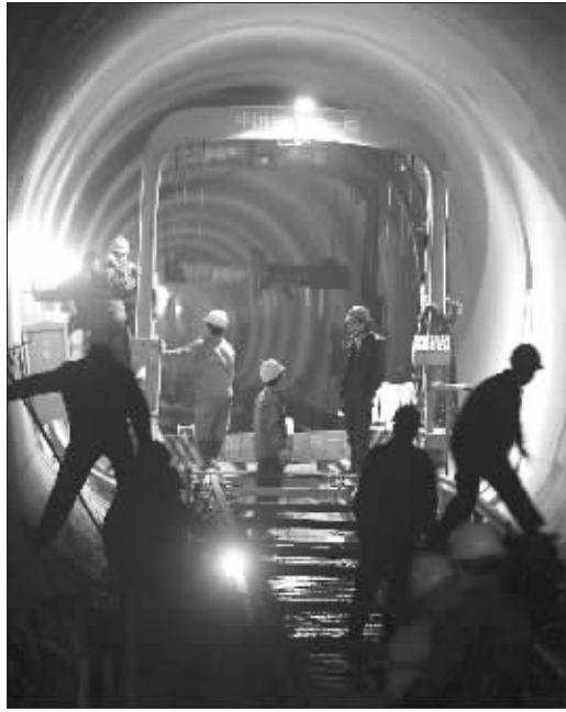
地铁二号线钢轨铺设现场
