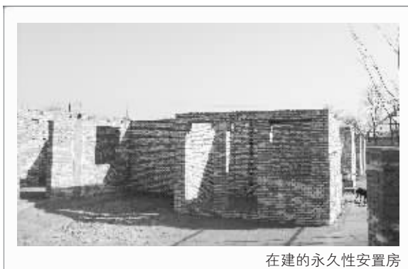
在建的永久性安置房
