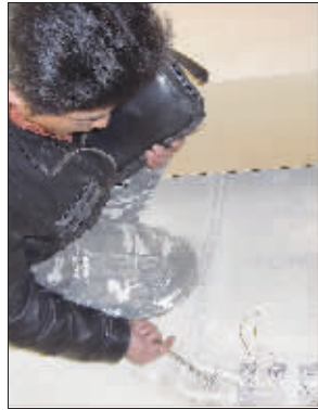
地插线管没有固定
