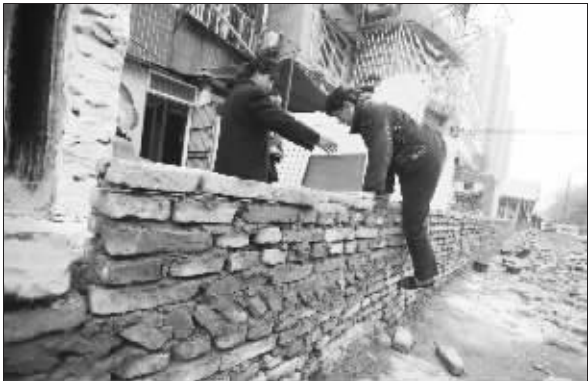
居民被正在修建的围墙堵在院子里 快报记者 唐伟超 摄
