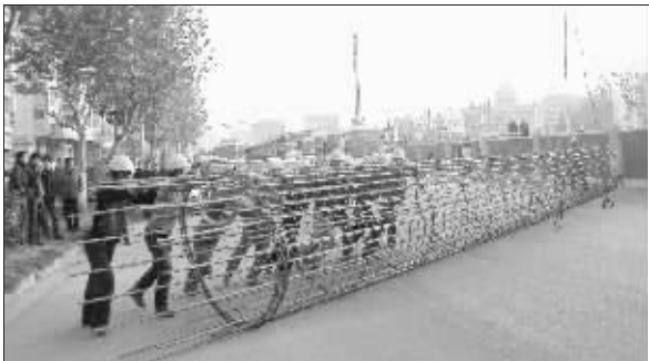
钢筋笼有10多米长 快报记者 孙玉春 摄
