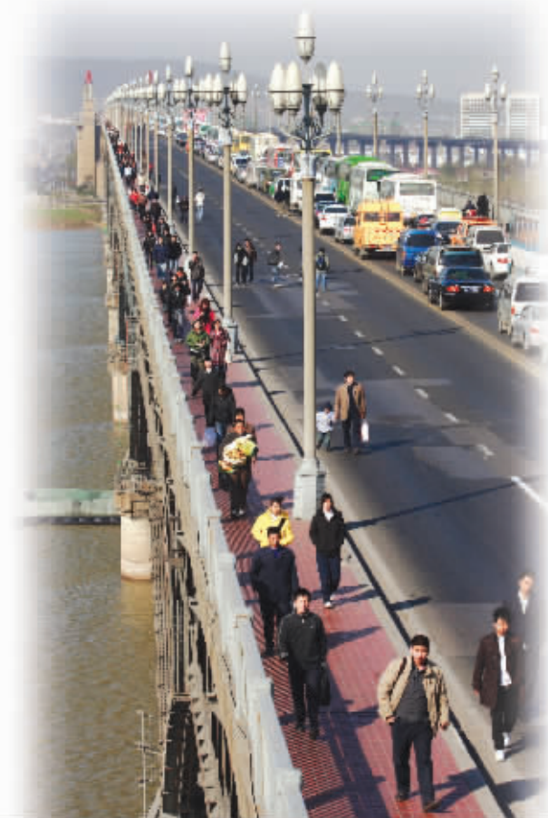
昨天,交通管制一度让大桥半幅路面空空荡荡 快报记者 洪波 摄
