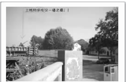
工地和学校之间砌了一堵围墙(本组图片均为网友提供)
