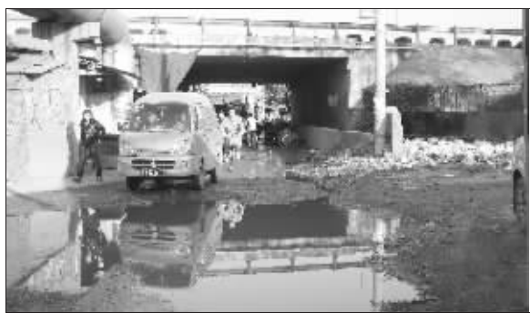
桥下常年积水,垃圾成堆
