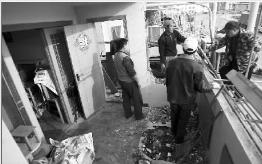
昨天下午,南苑街道城管拆除了平台上的违建 快报记者 唐伟超 摄
