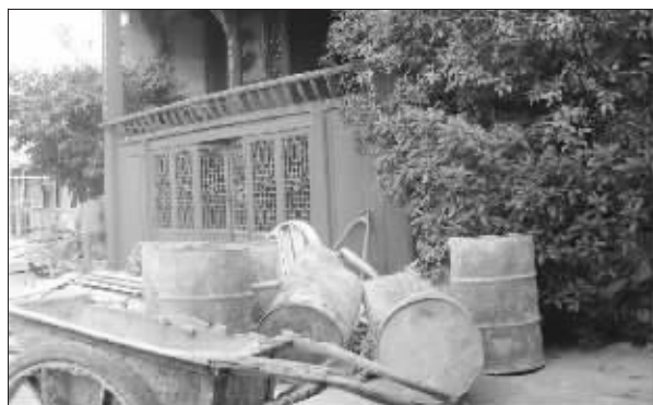
高淳东坝古戏台有着悠久历史,是省级重点文物保护单位。前天记者发现,古戏台边上堆放了大量建筑材料,几个民工为了方便施工,还把电源接线板挂在古戏台上,一旦失火,后果不堪设想。
