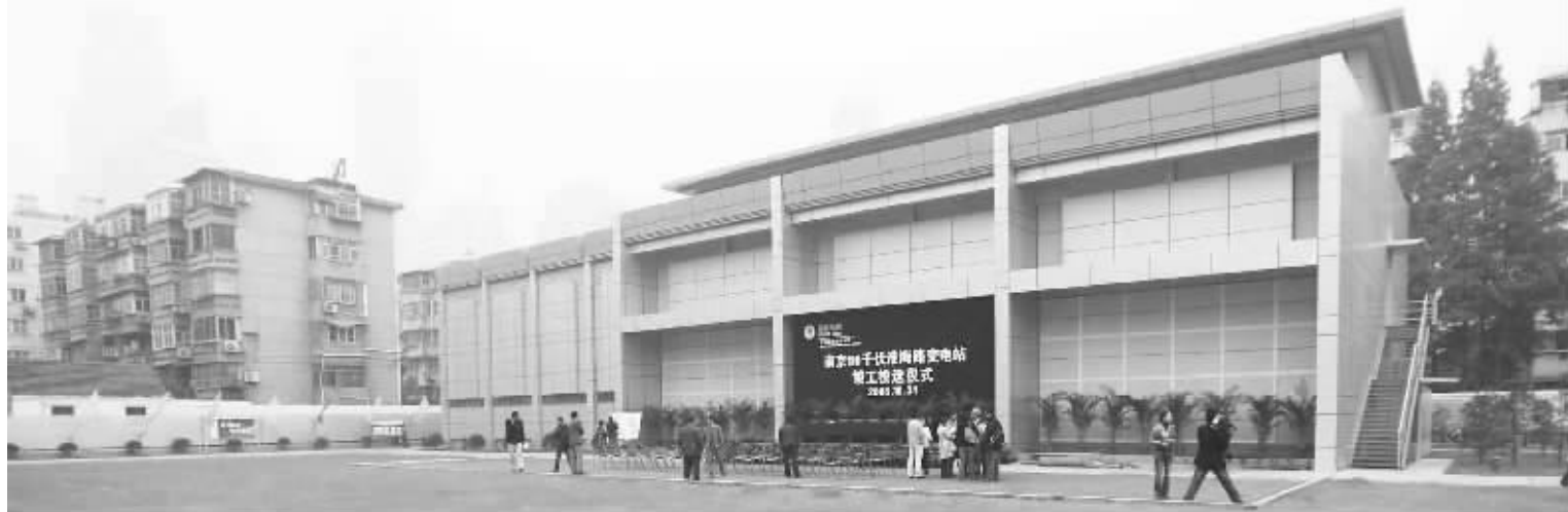
昨天,南京淮海路变电站正式投运,这是南京市5年来投运的首座城市中心变电站 快报记者 唐伟超 摄
