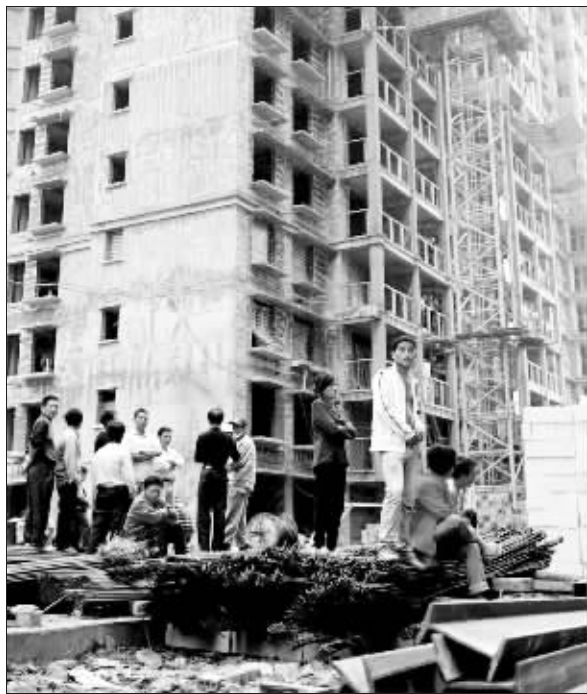
10月30日,霞浦县阳光城房地产开发施工现场。
