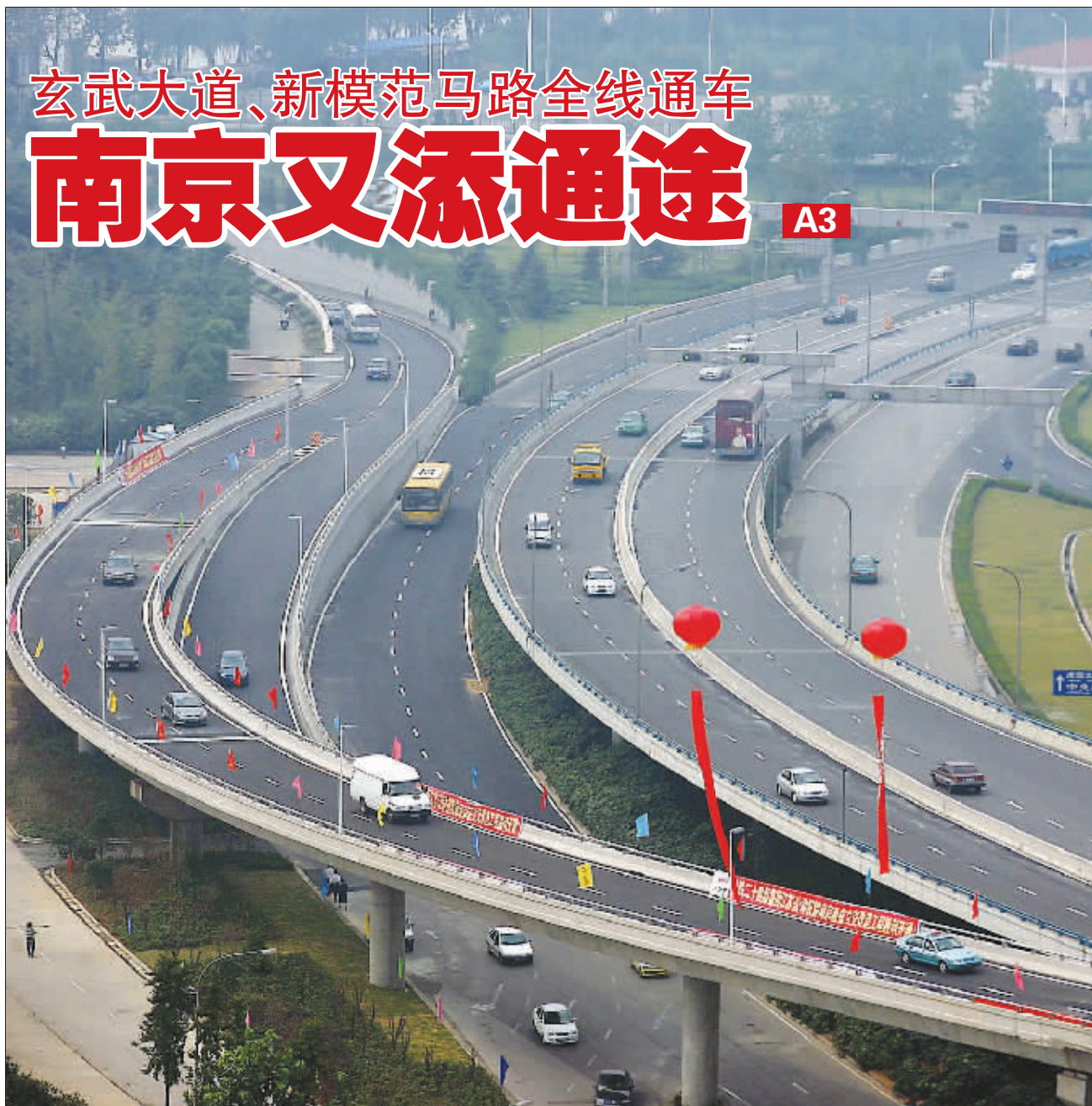
昨天,南京主城东北方向的新庄立交玄武大道快速化改造工程全线通车,城西的重要干道新模范马路恢复全路面交通。一东一西两大道路的通车,使得主城拥堵状况有望得到彻底改观。图为新庄立交玄武大道快速通道改造工程鸟瞰。 快报记者 顾炜 摄
