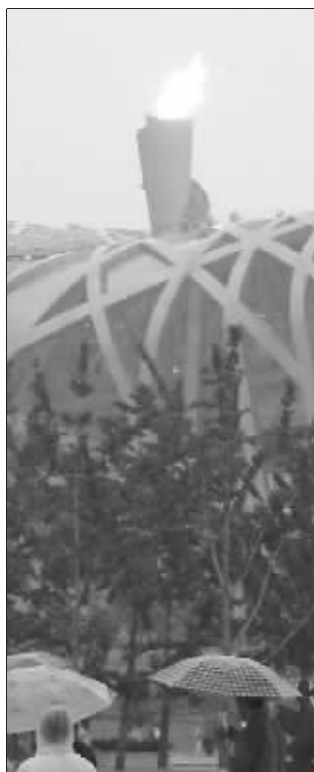
大雨中奥运主火炬熊熊燃烧 郑春平 摄
