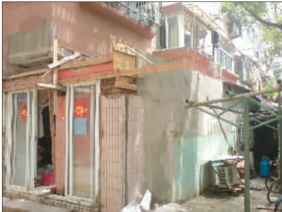
不少后院小屋已经封顶
