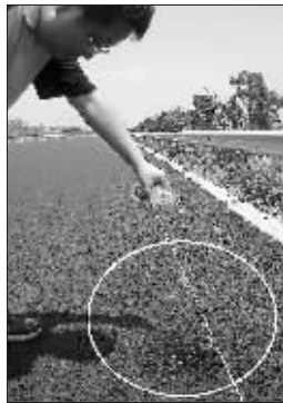
宁杭二期采用的是排水沥青路面 快报记者 顾炜 摄
