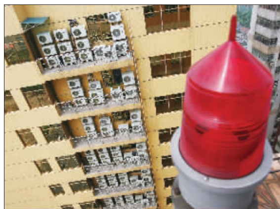
一幢高楼的外墙上挂满了空调。随着天气越来越热,用电量急剧增加,南京拉响了限电警报。快报记者 唐伟超 摄
