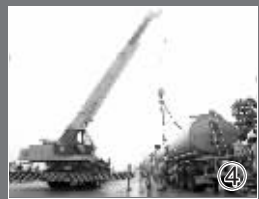
④一辆吊车把槽罐车吊起
